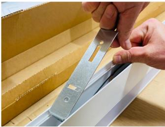
3. Per il fissaggio delle staffe è necessaria l'installazione di un tassello adeguato alla parete dove verrà installata la lampada. Per eseguire un'installazione corretta,
